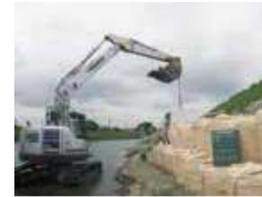
多くの人の安全を保ち、快適な環境をつくるために欠かせないのが維持管理工事。栃木県からの業務委託を受け、道路の除草作業を始め、災害時の緊急対応（台風での倒木撤去や洪水による河川氾濫防止のための土壌積など）を行っています。
